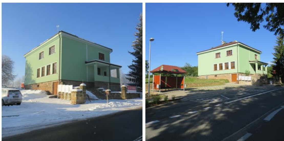
Obrázek 3 Budova Obecního úřadu Horní Olešnice
