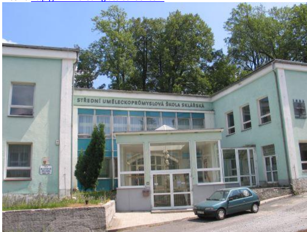
Obr. 5.5. Vstup do objektu Střední úměleckooprůmyslové školy sklářská Kamenický Šenov, zdroj: http://stredniroku.cz/skoly/113/
