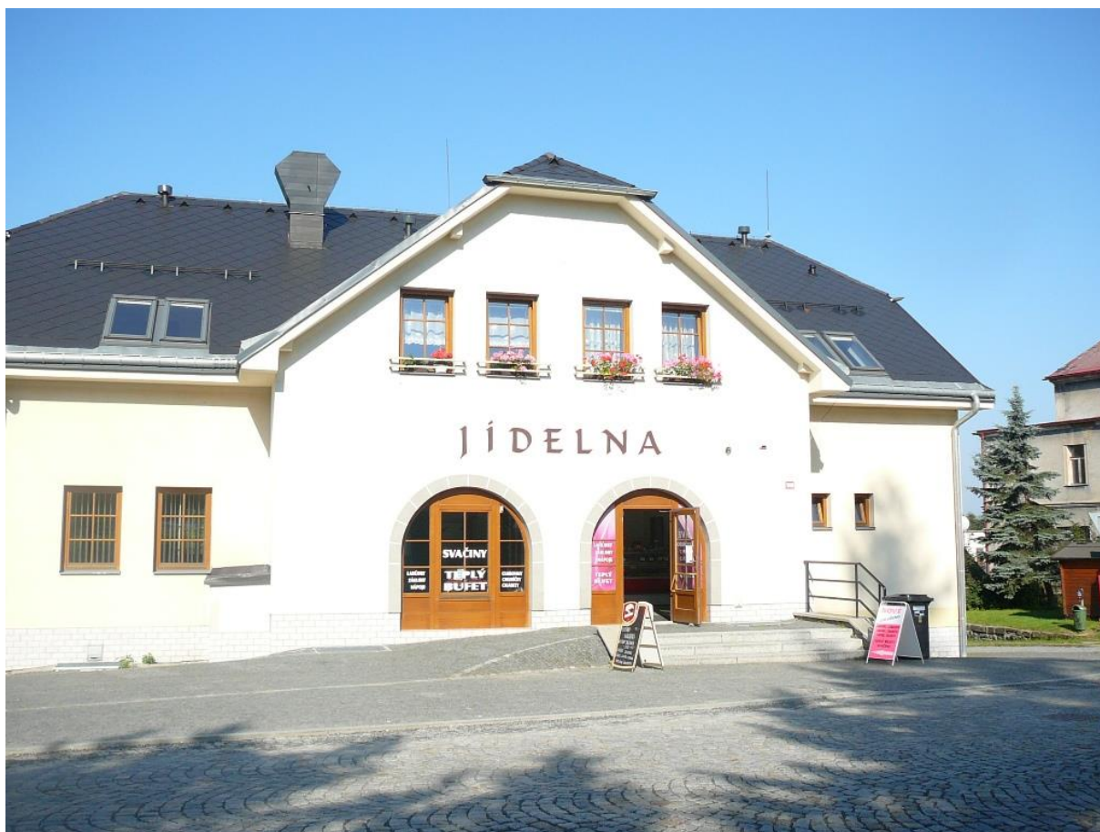
Obr. 5.8 Dům s pečovatelskou službou – objekt B, zdroj: https://dpsks.webnode.cz/
