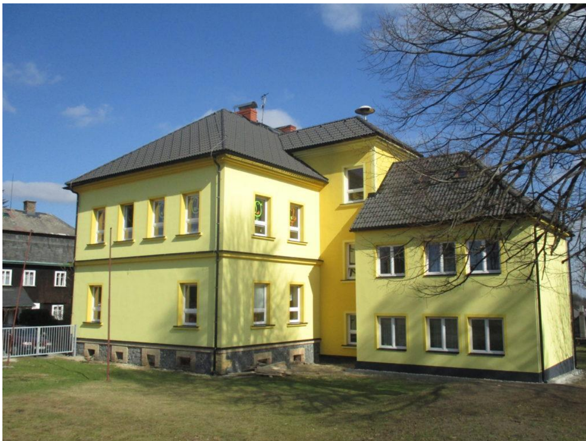
Obr. 5.4 Budova ZŠ a MŠ Prácheň, zdroj: http://www.skolaprachen.cz
