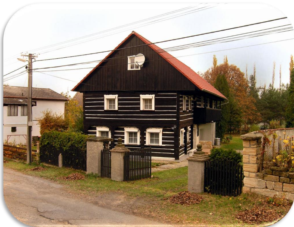
Obrázek 4: Roubený podstávkový dům č. p. 10 na severní straně návsi
