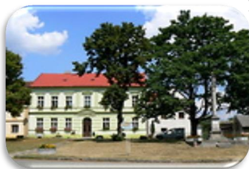
Obrázek 11: Budova Základní školy
