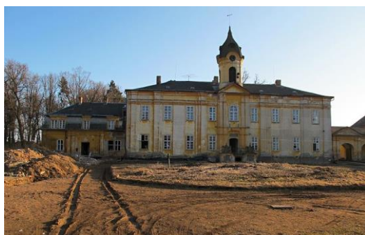
Obrázek 7 Zámek před rekonstrukcí
