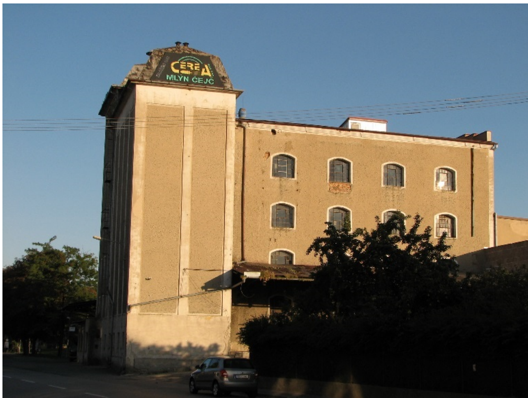
Obrázek č. 10: Budova mlýna v Čejči
