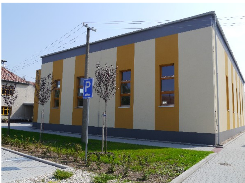
Obrázek č. 7: Multifunkční hala v obci Ladná
