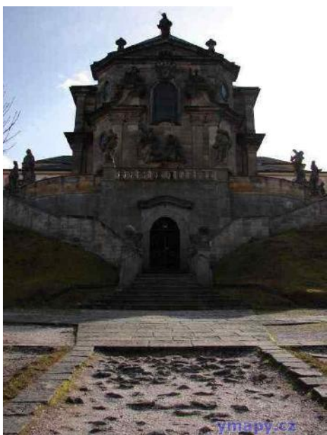
Hospital Kuks, vzdálenost 7 km
