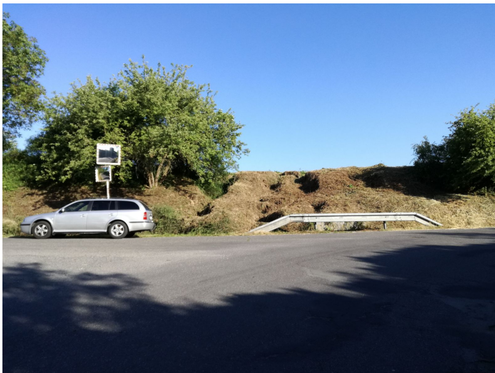
Obr. č. 7: Místo ohrožené erozí půdy
