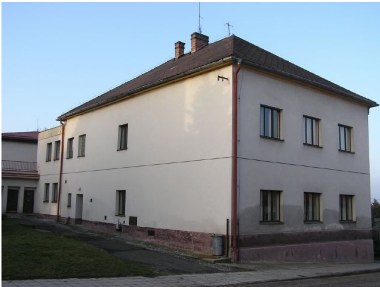
Obrázek 12 Budova bývalé ZŠ Mlázovice v roce 2005
