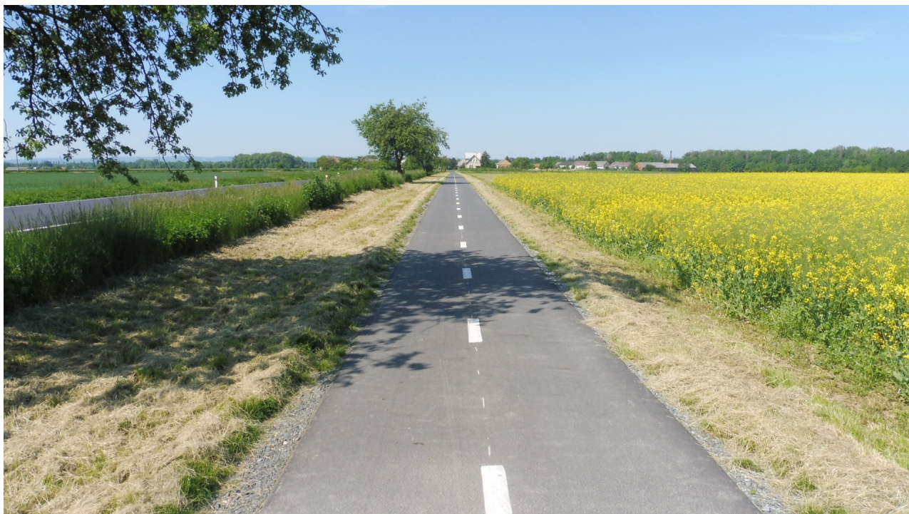
Obr. nově zbudovaná cyklostezka v obci Dlouhá Loučka - Horní Sukolom Zdroj: obec Dlouhá Loučka
