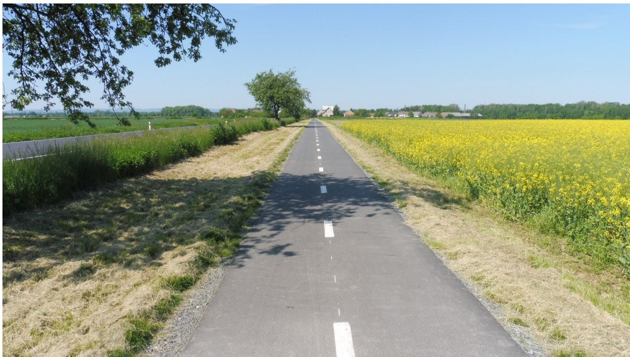
Obr. nově zbudovaná cyklostezka v obci Dlouhá Loučka - Horní Sukolom Zdroj: obec Dlouhá Loučka
