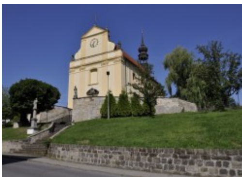
Kostel sv. Petra a Pavla - čelní pohled
